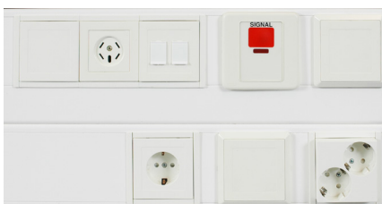
Uttagen för exempelvis antenn, tele och data monteras av Qmt, men leverantören av utrustningen installerar tjänsten på plats.
